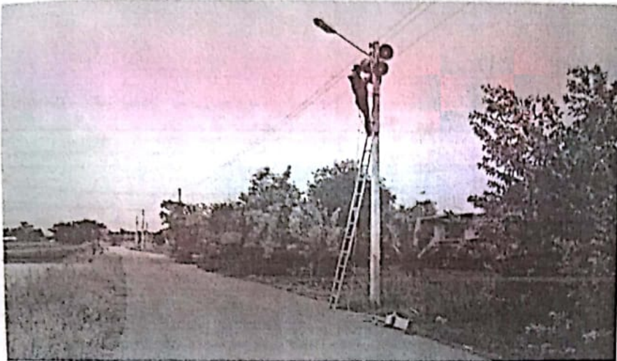
ทำการติดตั้งที่เสาเป้าหมายที่หน่วยงานกำหนด
